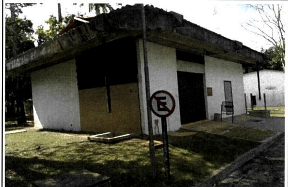
VISTA DA SUBESTAÇÃO
