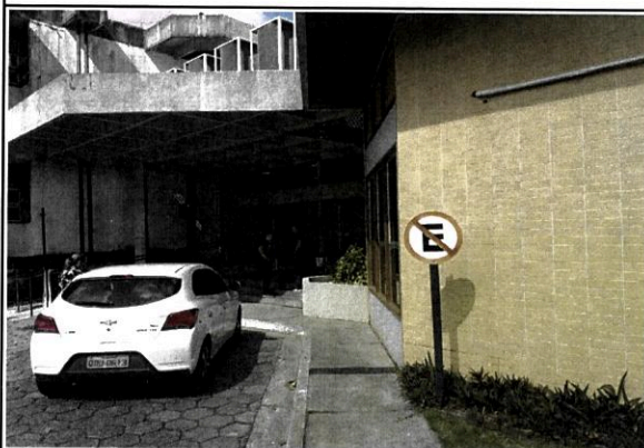
VISTA DA ENTRADA PRINCIPAL DA SEDE
